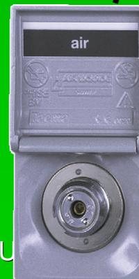
A chaque lit, des prises avec un crantage spécifique au gaz permet de brancher du matériel de mise en œuvre des gaz
